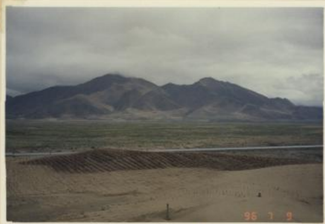
1994年10月扎设在江乡段中居公路上的草方格防护沙障 经两个风季后，依然未刮垮。 图为：96年7月9日拍摄
